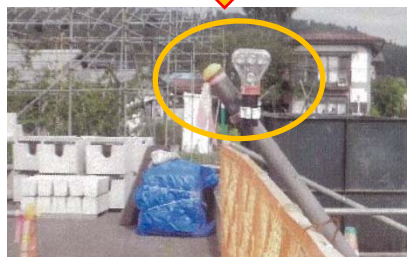
▲接触防止のため単管突出 箇所点滅灯を付けた
