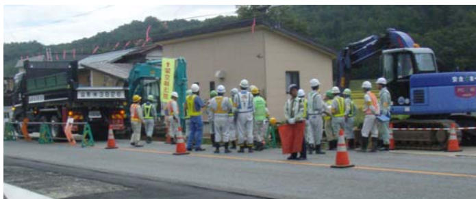
▲道路改良舗装工事の現場点検
