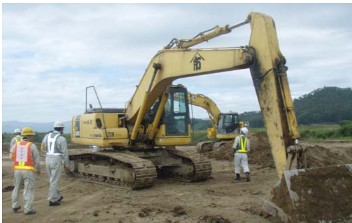
▲河川敷における工事の現場点検
