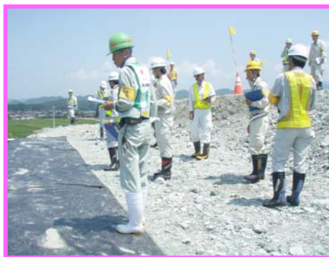
▲現場点検の様子
