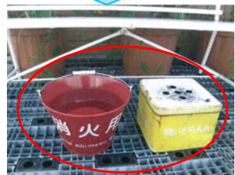
▲消火用バケツを設置
