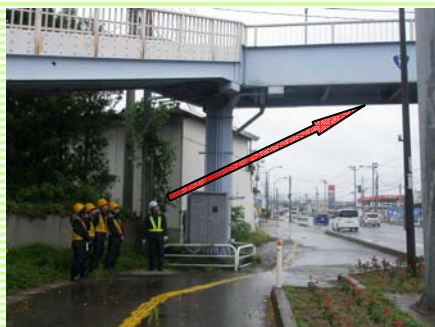
▼歩道橋の下から点検
