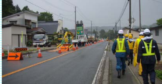
▲片側交互通行にして工事をしている様子
