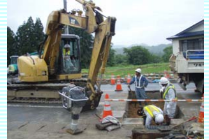
▲横断排水管を埋設している様子
