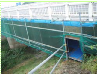
▲補修・補強工事を行うために、橋の下に組まれた足場
