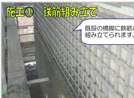
既設の橋脚に鉄筋が組み立てられます。
