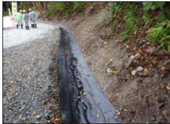
浸食を防ぐための土側溝のシート
