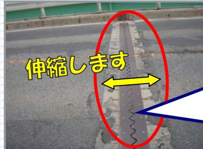
伸縮装置（ジョイント）とは、温度変化などによる橋の伸縮をスムーズにするとともに、自動車などがスムーズに走行できるようにするための継手です。
