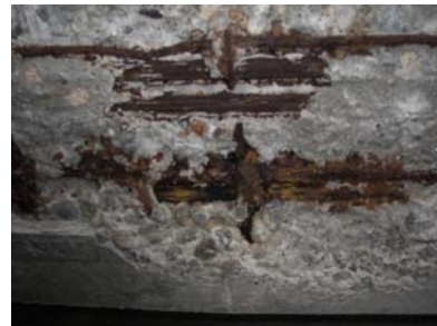
鋼材がさびている様子
