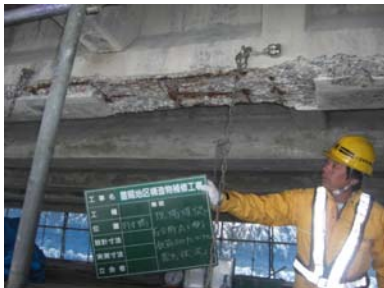
橋桁の損傷状況
