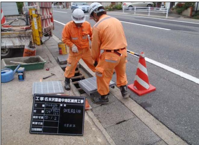
②側溝蓋交換作業：鉄製の側溝蓋（グレーチング）は重量が40.3kgもあります。
