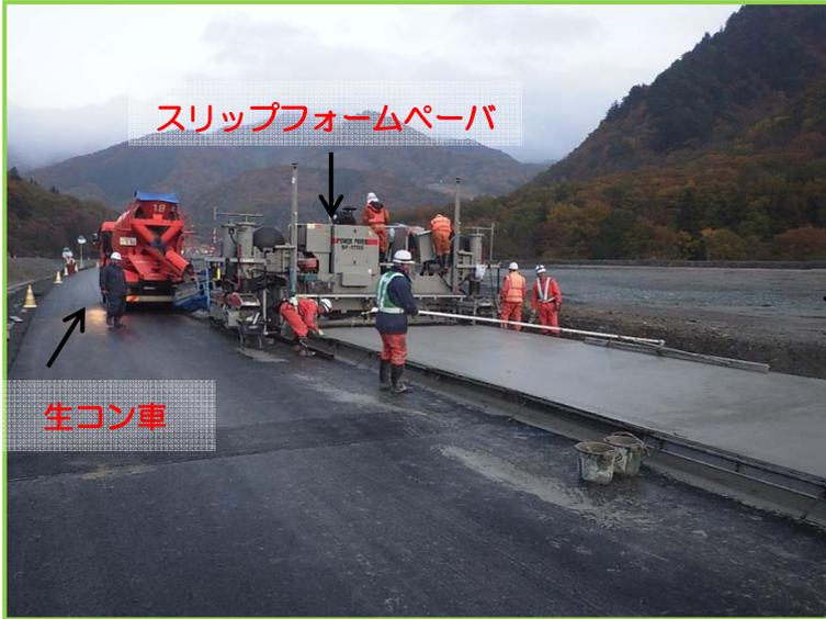
従来の舗装では、型枠を設置してその中にコンクリートを流し込む作業を行っていました。しかし、今回の工法では型枠が不要となるため工事の省力化、および工期短縮ができる技術です！
