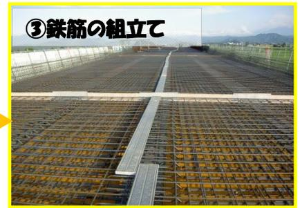
φ13mm～φ22mmの鉄筋を組み立てていきます。
