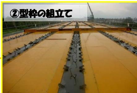
橋桁の上に木製の型枠を設置します
