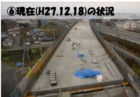
床版が完了し、高欄、中央分離帯の施工を行っています
