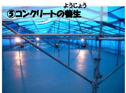
コンクリートに欠陥が発生しないように一定の温度(5℃以上)を保ちます。
