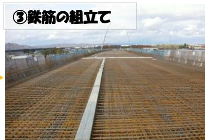
φ13mm～φ22mmの鉄筋を組み立てていきます。
