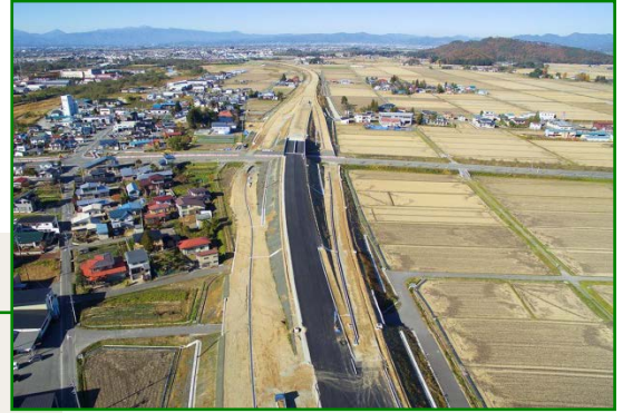
▲舗装工事が進む米沢中央IC（仮称）
