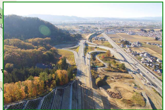
▲土工工事が進む米沢IC（仮称）
