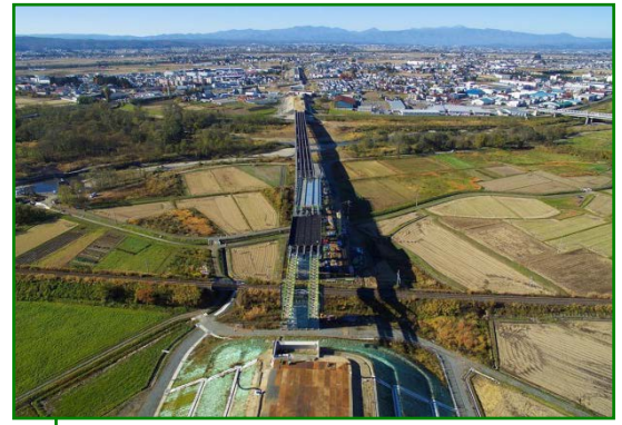
▲架設工事が進む米沢大橋（仮称）
