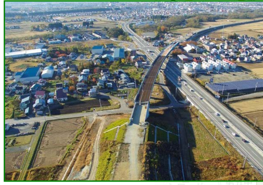
▲床版工事が進む万世高架橋（仮称）
