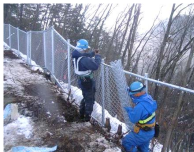
↑ 柵の設置作業
