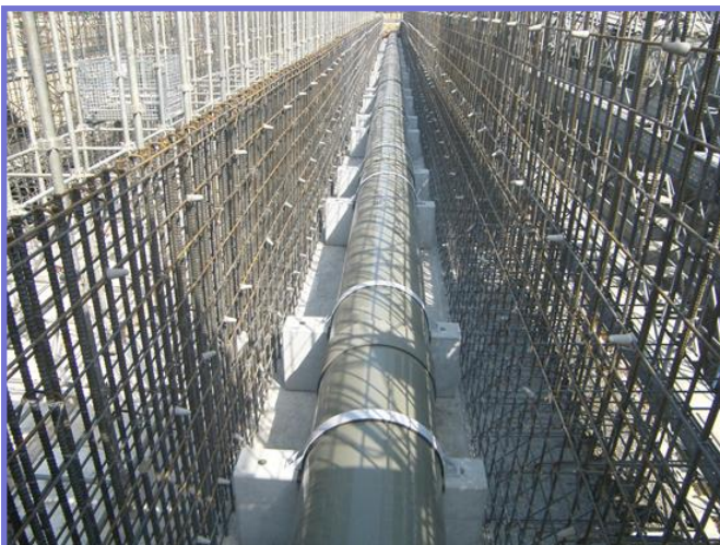
↑ 設置完了 全長約100メートル
