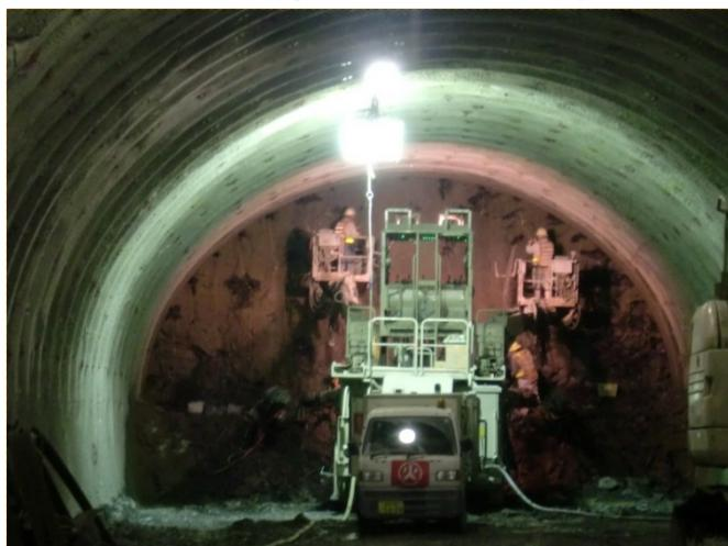
←ドリルシャンプで穴を開け、火薬を詰め爆破に向け作業している様子
