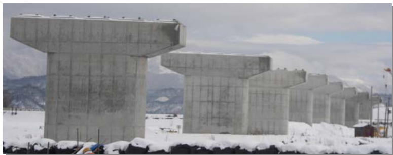
↑ P8付近から完成した橋脚を望む
