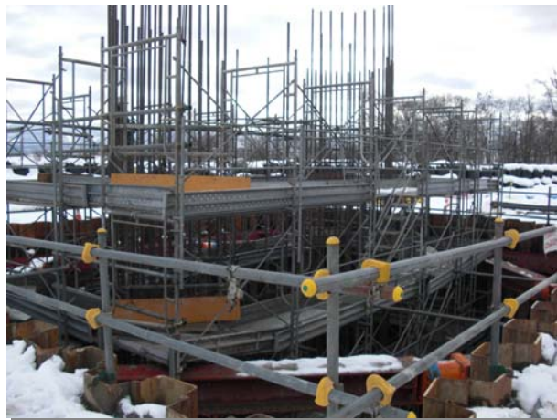
↑ P9 鉄筋組立の様子
