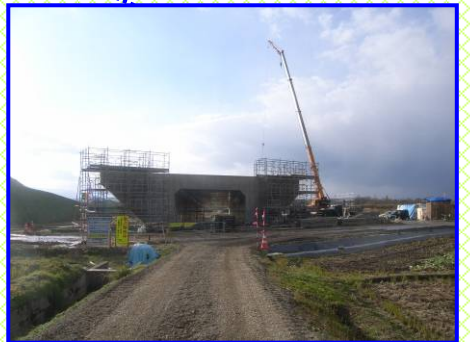
◆道下道路改良工事◆ 道路ボックス施工中
