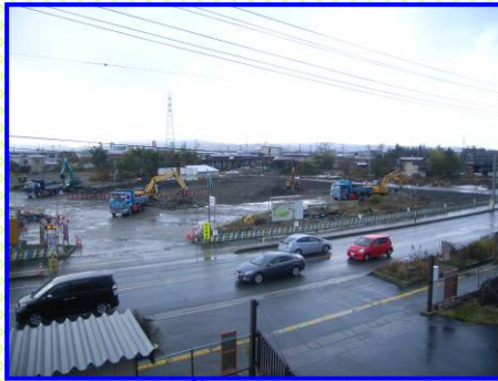
◆道ノ上地区道路改良工事◆ 構造物撤去状況
