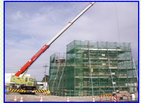
◆中田高架橋下部工工事◆ 橋台施工中
