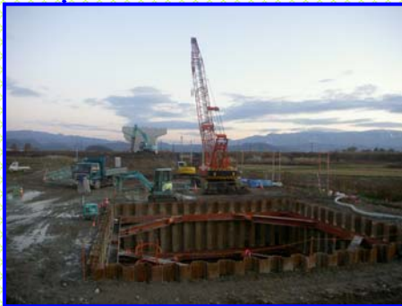
◆米沢大橋下部工工事◆ 橋脚施工中
