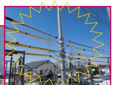
施工中の橋脚のすぐ隣に電柱があるため、このように電線にカバーをして、事故に注意しながら作業を進めています！
