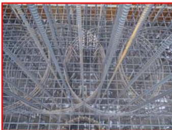
P3 橋脚(高さ12m)では主筋の周りにフープ筋を15cm間隔で配置します！
