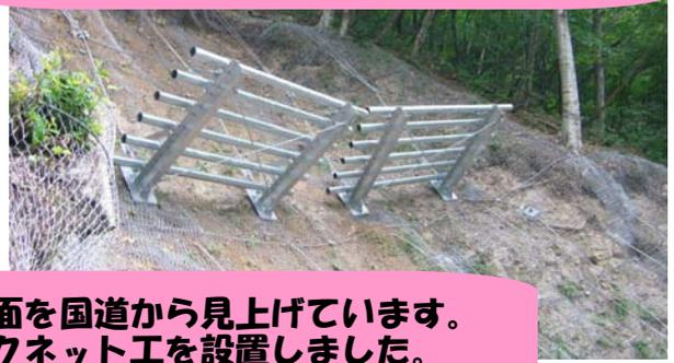
防災対策後の法面を国道から見上げています。落石を防ぐロックネット工を設置しました。
