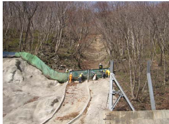
落石防止柵に溜まった石や斜面の浮きを落とします
