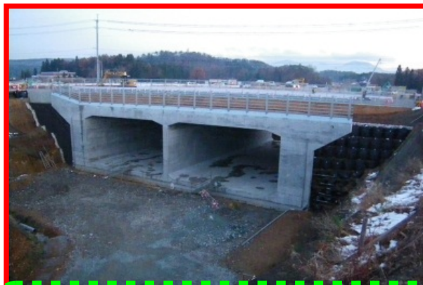
市道南原大石田線下のBOXが完成し、昨年11月に市道を本線へ復旧(26号)(尾花沢構造物工事:柿崎工務所)
