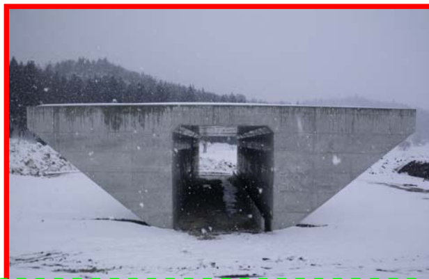
沢の目川付近の農道上に完成したBOX (沢田地区道路改良工事：力キザキ)
