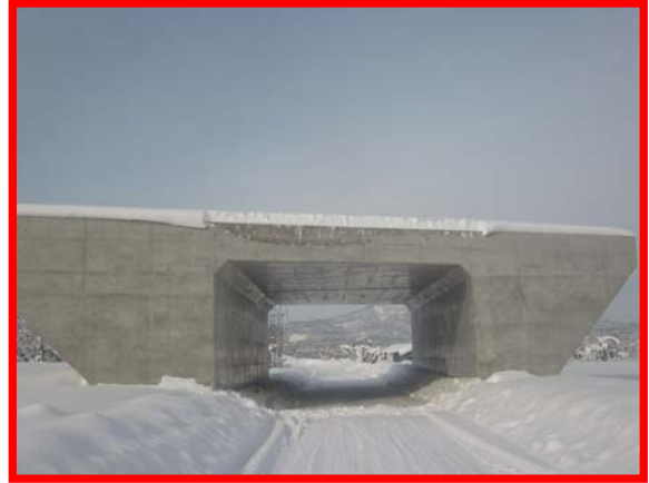
【東北中央道】道路BOX（村山市道沼田赤石線）上の雪庇を処理
