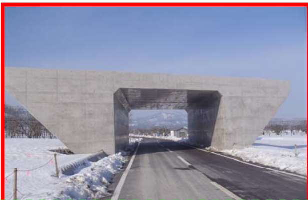
市道沼田赤石線上に完成したBOX(25号) (本飯田道路改良工事：高谷建設)
