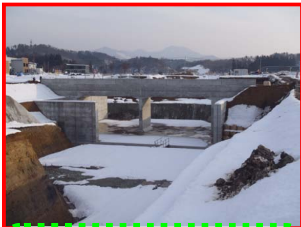
水路付替BOX及び擁壁工の一部が完成(27号)(下新田構造物工事:カキザキ)
