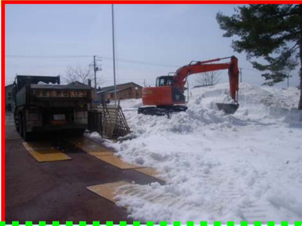
排雪で広場復活！子供達にも笑顔復活！ これが縁で昨年6月イベント実施（19号） （福原地区道路改良工事：新庄砕石工業所）
