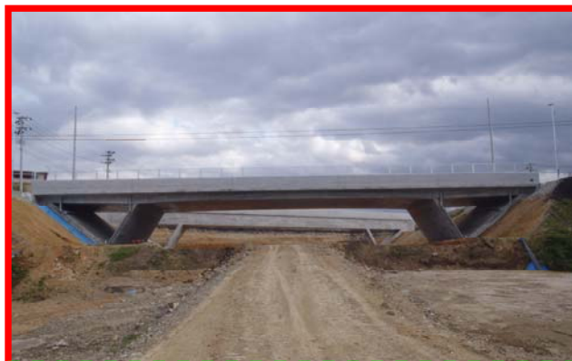
尾花沢こ道橋(県道尾花沢大石田線)が完成し、昨年5月に県道を本線へ復旧(19号)(尾花沢地区橋梁設置工事:昭和コンクリート)(大石田北部道路改良工事:升川建設)
