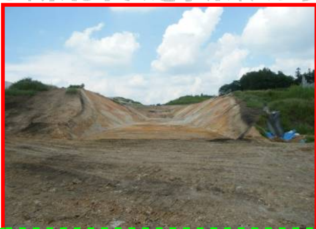
今宿地内の切土一部が完成(22号) (大石田南部道路改良工事：はながさ建設) (沼田地区道路改良工事：柿崎工務所) (河原田地区道路改良工事：泰昌建設)
