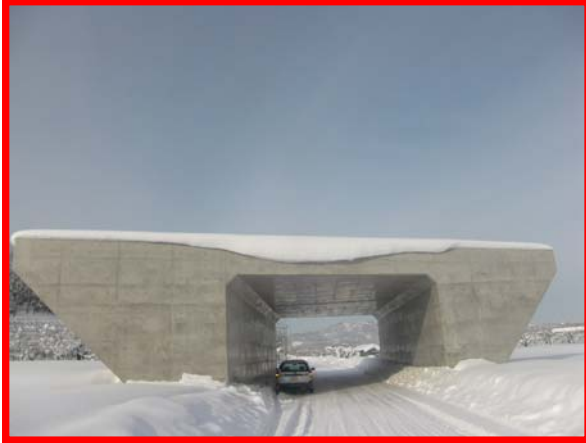
【東北中央道】道路BOX（村山市道沼田赤石線）上の雪庇を処理
