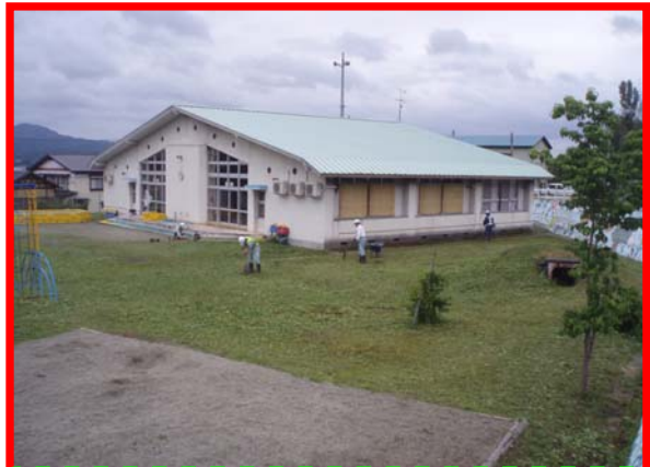
山から蛇が下りてくるといことで草刈り作業 を実施（土生田地区道路改良工事：柿崎工務所）
