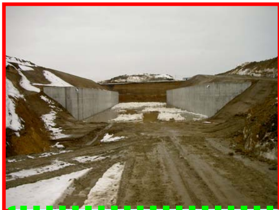
市道南原大石田線南側の擁壁工一部が完成(南原構造物工事:升川建設)
