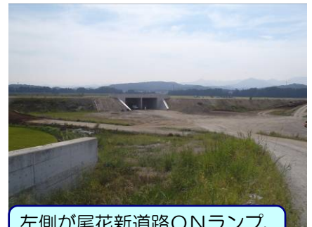
左側が尾花新道路ONランプ、中央はICの函渠工
