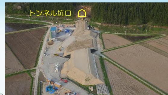
▲ 工事状況 全景
