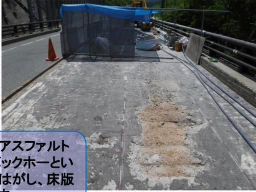
約5cmのアスファルト舗装をバックホーという機械ではがし、床版を出します。
