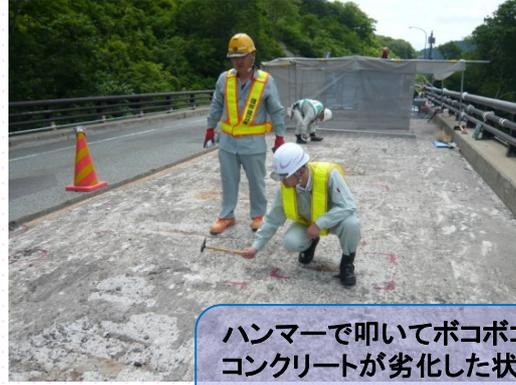
ハンマーで叩いてポコポコと鈍い音がしたら、コンクリートが劣化した状態。補修範囲にカッターで切れ目を入れ中を確認します。
