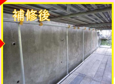
寒冷期の凍害などで劣化した壁に、融雪剤(塩分)を含んだ水が浸入することにより中の鉄筋が錆び、鉄筋の周りのコンクリートが浮いてしまっています。コンクリートをはつき、新しいコンクリートで固め、健全な状態にしていきます。
