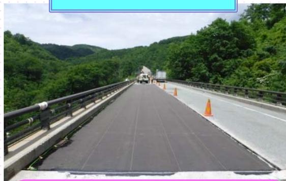
防水シートを敷き水の浸入を防ぎ、長い間安心して橋を通れるようにします。
