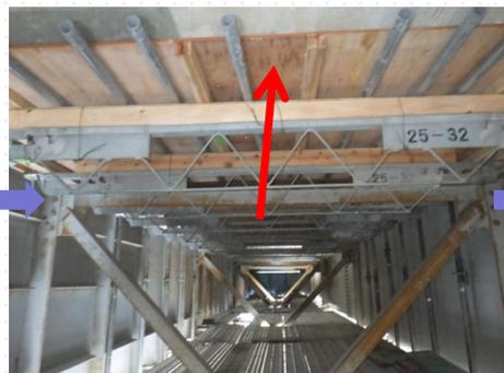
パイプと鉄筋の間に板を挟んで固定します
