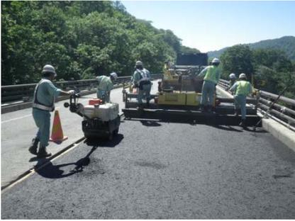
『アスファルトフィニッシャー』でアスファルト合材を敷きならします。
