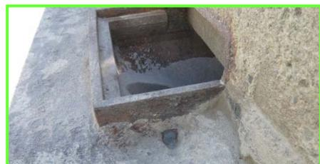
↑アスファルト舗装から浸透した水は防水シート上の排水柵から外へ排水。
