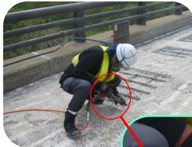
土砂化した部分や浮いている不健全なコンクリートを撤去し、健全なコンクリートに置きかえる準備をします。
