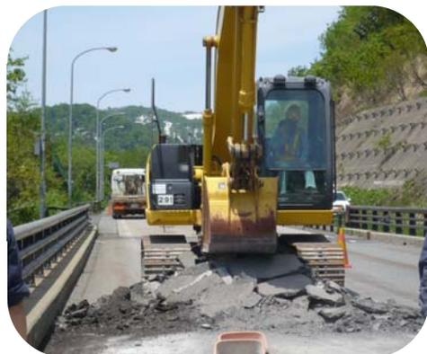
約5cmのアスファルト舗装を『バックホー』という機械ではがし、床版を出します。
