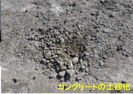
重車両が繰り返し通ること、その重さや振動でアスファルト舗装にヒビが入ります。そこから浸入した水と、寒冷期の凍結により、中の鉄筋が錆び、鉄筋の周りのコンクリートが浮いてしまいます。そうすると上からの振動で、浮いたコンクリートが細かく砕け土砂化し、舗装のヒビから吹き出しとして現れます。
