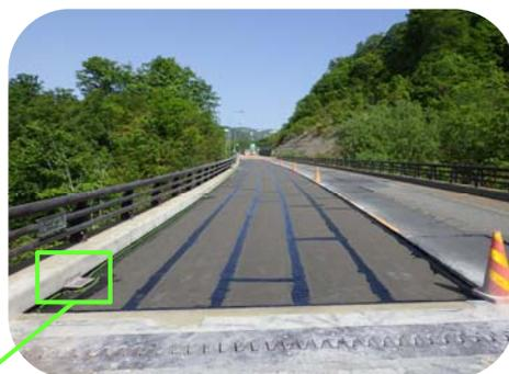
アスファルト舗装はわずかですが水を通すため、中の鉄筋が錆びてしまいます。錆が発生することにより橋の強度に影響が出て、橋の安全性を長期間保つことが難しくなります。そこで、防水シートを敷き水の浸入を防ぎ、橋を錆から守り、長い間安心して橋を通れるようにしています。
