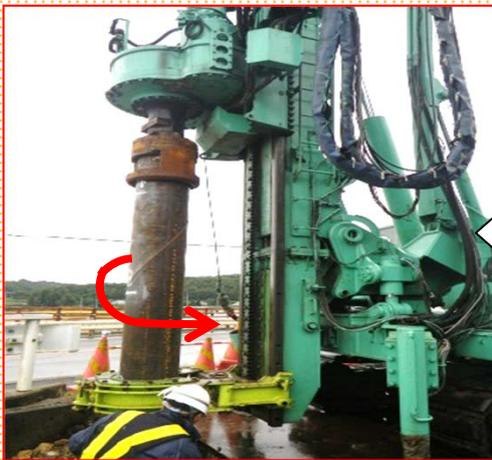
重機を使い、杭を回転させながら所定の深さまで打ち込みます。ネジを回し込むようなイメージです。
