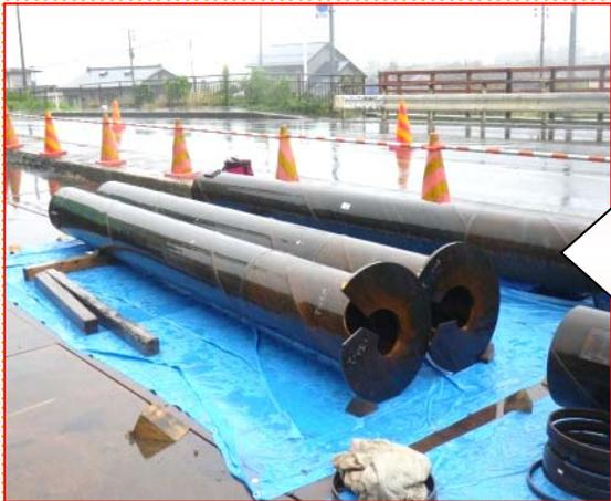
長さ4.5mの鉄で出来た杭を合計8本打ち込みます。
