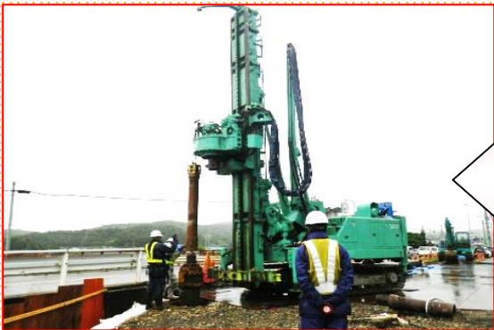
今回は住宅地近隣での施工になるため、なるべく騒音が出ないように杭を専用の重機で回転させながら打ち込む工法を用いました。
