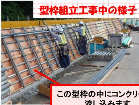
この型枠の中にコンクリートを流し込みます
