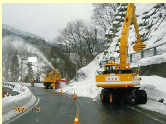
雪崩を防ぐため法面に溜まった雪を取り除く作業をしています
