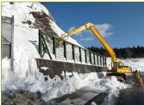
雪崩を防ぐため法面に溜まった雪を取り除く作業をしています
