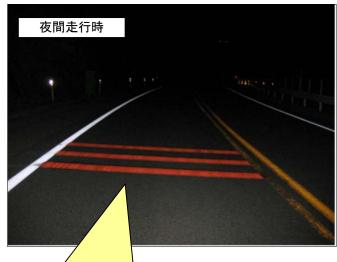
急カーブで見通しの悪い箇所・急勾配でスピードの出やすい箇所の手前に凹凸のある減速ラインを施工しました。実際に車で走ってみると、「ガタ通じッ!」という音と振動がタイヤを通じてはっきりと伝わってきます!
