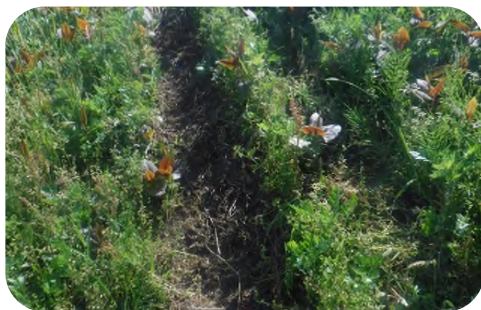
▲ 損傷した堤防 法面(表法面)に残されたタイヤ跡。法面を保護している植生が踏み荒らされている。
