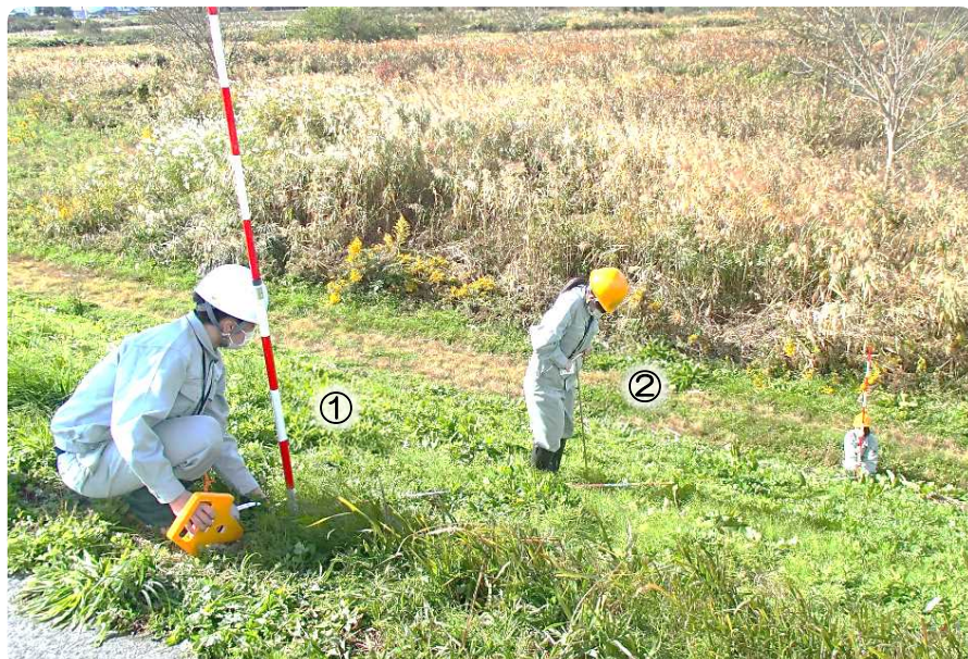
▲堤防モニタリング調査に挑戦！①傾斜角度を測定し、堤防の形状を確認します。②貫入棒を押し込むことで、堤防の強さを測定します。
