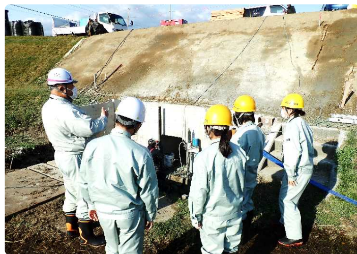
▲工事現場見学。堤防に設置された「樋管」のゲートを新しく交換する工事。既存樋管の取り壊し状況を見学しました。
