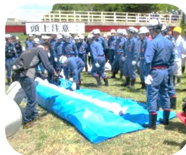
▲ 改良積土のう工法
