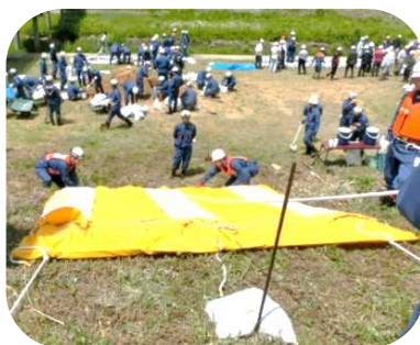
▲ 水防マット工法
