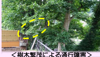
＜樹木繁茂による通行障害＞
