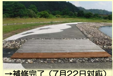
→補修完了(7月22日対応)
