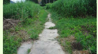
↓堆積物の除去(即日対応)
