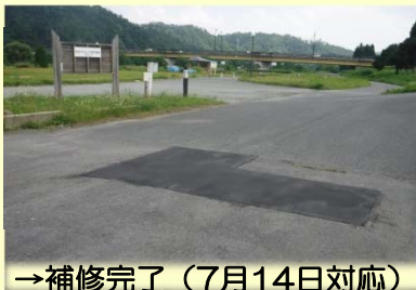
→補修完了(7月14日対応)
