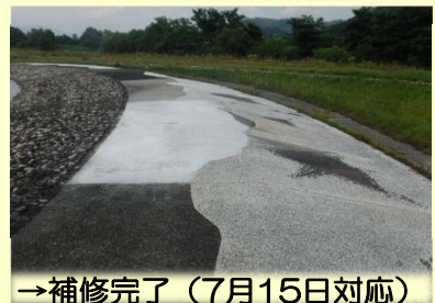
→補修完了(7月15日対応)
