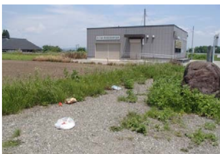
《7》最上川 左岸 No.93- 窪田水防倉庫脇 家庭ゴミの投棄
