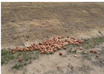
《4》最上川右岸 No.37+ 下田橋下流 堤防表坂路法尻附近への果樹屑（林檎）の投棄
