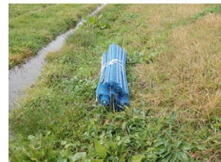
《23》吉野川左岸No.7- 棒川樋管下流 裏法尻 すだれの不法投棄
