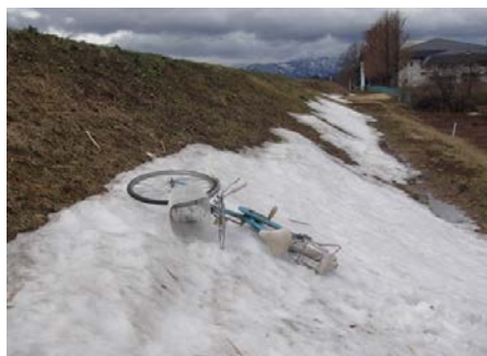
《1》最上川右岸 No.46+ 湊郷堰下流 川裏法面の放置自転車
