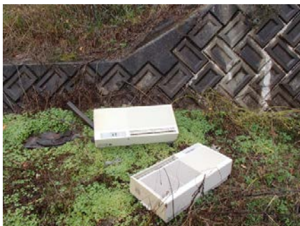
《22》最上川左岸No.77- 米沢南陽道路法尻 エアコン室内機の不法投棄
