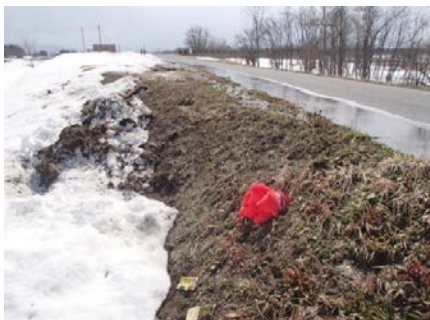
《31》最上川左岸No.91+ 置賜橋下流川裏法面 雑貨ゴミの投棄
