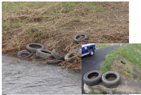
《5》和田川右岸 No.6+ 和田橋下流 右岸側河岸に8本左岸側法面橋台に3本タイヤの投棄
