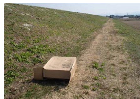
《3》最上川左岸 No.38+ 下田橋下流 裏小段へのダンボールの投棄
