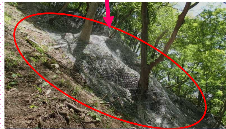
岩石が露出している斜面には、落石の発生を防ぐネットを張りました。
