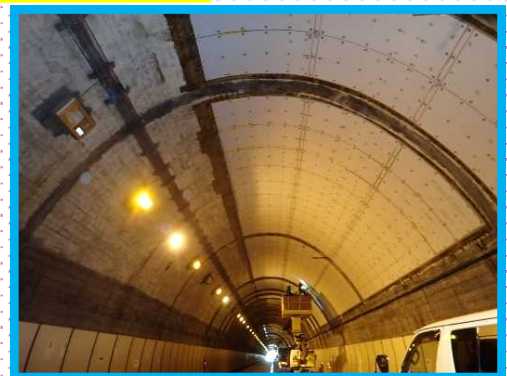
パネル設置状況
