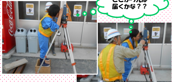
測定点にフリスム反射鏡を置き反射してくる光波により距離を測定します。
