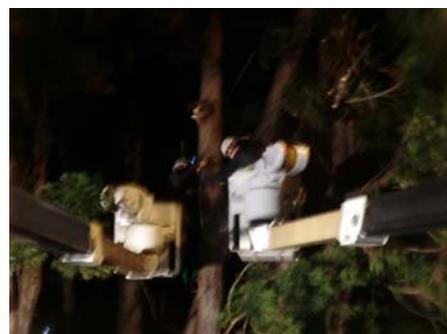
電線の所有者である東北電力と調整し、隣の杉にワイヤーで連結する応急処置を行っていただきました。
