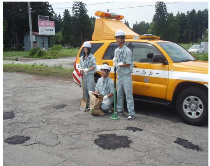
「パッチング」と言い、路面に生じた穴やひび割れ部分にアスファルト混合物を詰めて補修します。
