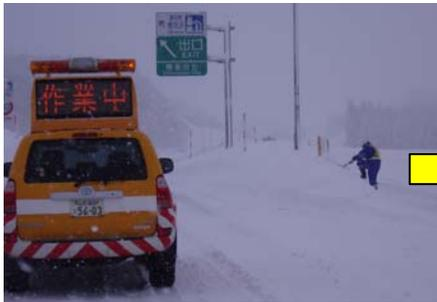
雪で中央分離帯のブリンカーライトが見えにくくなっています。道路附属物がきちんと役割を果たせるようにします。
