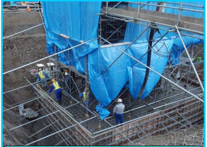
橋脚の土台部分にコンクリート打設中
