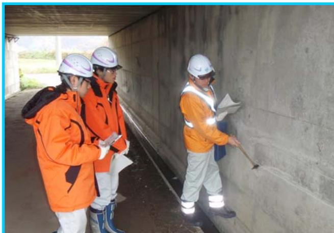
橋梁点検をしてみよう。テストハンマーで空洞がないか確認(左)、壁面のヒビを計測(右)。
