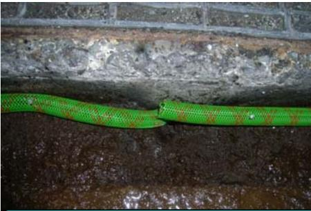
排水性舗装にしみこんだ雨水を通す管を設置します
