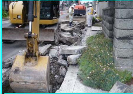
バックホウでコンクリート片を撤去します
