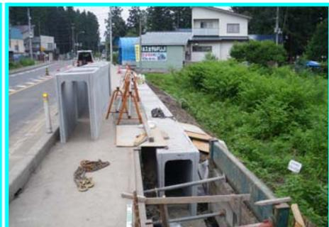
掘り終えて基礎をつくったところに、新しい流雪溝を設置します
