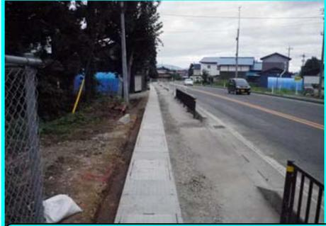
流雪溝の設置完了 これから歩道の拡幅を行います
