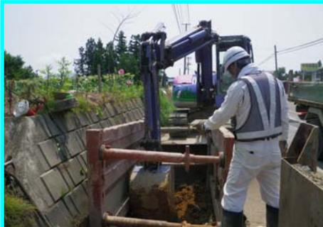
新たに流雪溝を設置する箇所を掘っていきます
