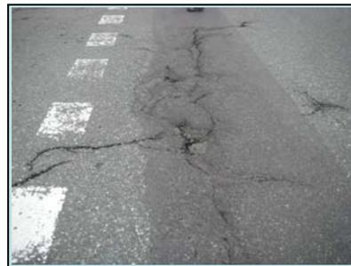
一冬越えて雪解け後の4月～5月は、舗装がボロボロ。パンクなどの事故防止のためにも補修が不可欠です。
