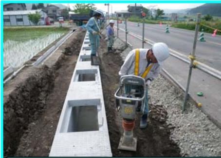
側溝のまわりに土を盛って締め固めます
