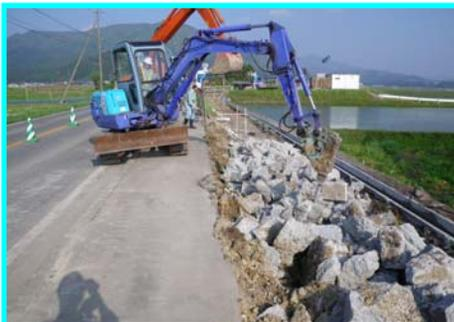
路肩拡幅のために、歩道の壁を撤去します
