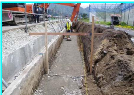
側溝設置箇所の地盤固め
