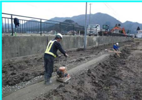
既設排水路移設箇所の基礎固め
