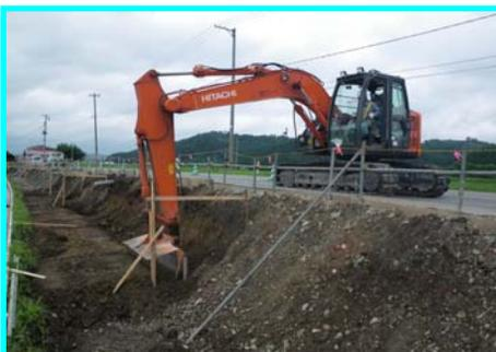
側溝設置箇所の掘削
