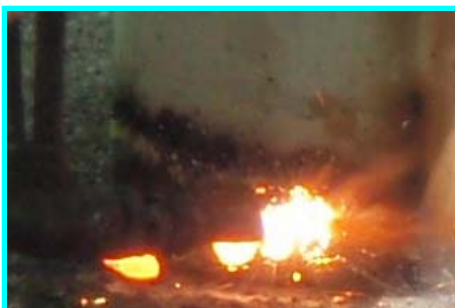
ガスで切断します
