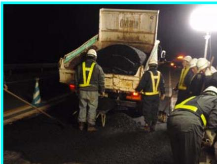
表層部分もアスファルトを敷きならして締め固めます
