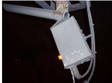
損傷した状態。受光部と本体が分離され、ケーブルが垂れ下がり、落下の危険がある。
