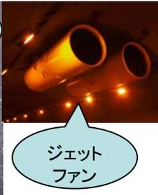
受光部で受けた光をレンズに到達させることで、トンネル内の煙の状況を把握します。排気ガスがこもっているときにはジェットファンが作動します。
