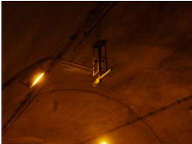
正常な状態。受光部と本体が一体となっていて、道路面と平行に設置されている。
