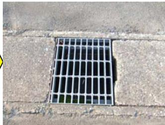
側溝蓋の間に、隙間ができていました。自転車の車輪が挟まれば、大ケガする可能性があります。
