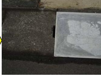
側溝蓋が劣化し、鉄筋がむき出しの状態です。
