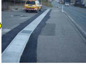
側溝蓋の劣化、ヒビ割れによるへこみなどが生じており、危険な状態だったので、補修しました。
