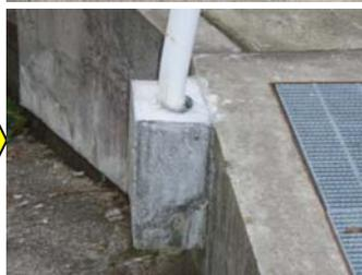
転落防止柵の取付部分が破損していました。歩行者や自転車の安全を守るためのものなので、補修しました。
