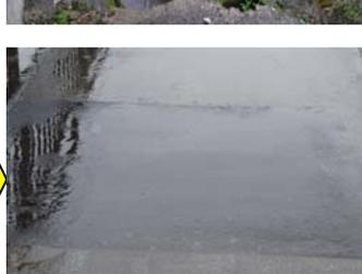
歩道の舗装が沈下していました。起伏が生じており、さらに雨天時には大きな水たまりができるため、補修しました。
