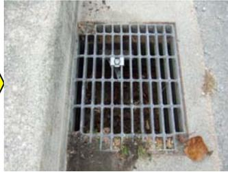
グレーチング蓋(網目状の蓋)に跳ね上がり防止金具がついていないと、車が上を通過した衝撃でグレーチングが跳ね上がり、事故に直結する場合がありますので補修しました。
