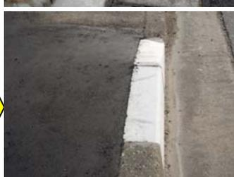
縁石ブロックの損傷に伴い、歩道に亀裂が入っていました。ブロックの損傷による事故のおそれや、歩行者・自転車にとっても危険なため補修しました。
